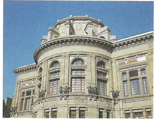
洪水の被害の大きかった国立図書館
